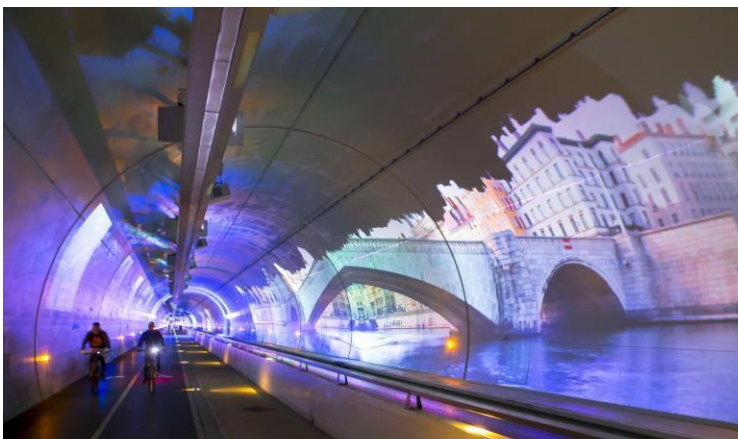
Lione, tunnel la Croix-Rousse
