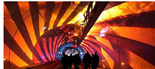
Lione, tunnel la Croix-Rousse
