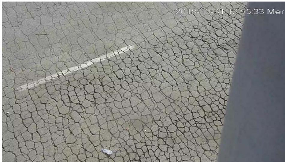
Pertanto i lavori di pavimentazione dell'area prevedono il rifacimento dell'intero pacchetto stradale nell'area di accesso e della parte superficiale del pacchetto della corsia di marcia, inoltre risulta necessario mettere in sicurezza il confine dell'area lato piazza Pio XI con lo spostamento dei new jersey e bonificare dalle essenze arboree la parte lato via Aurelia che ad oggi limitano l'utilizzo del parcheggio.
