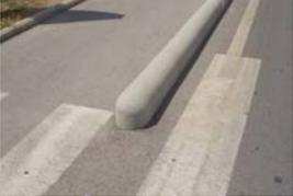
*Numana, elemento separatore stondato utile in contesto di necessità di contenimento ciclabile e della sosta*
