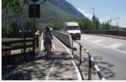
*Bolzano, new jersey asimmetrico, utile in presenza di traffico intenso, pesante e con necessità di contenimento ciclopedonale*
