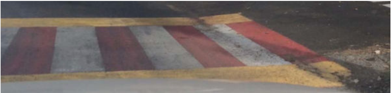
Attraversamenti pedonali ad effetto ottico
