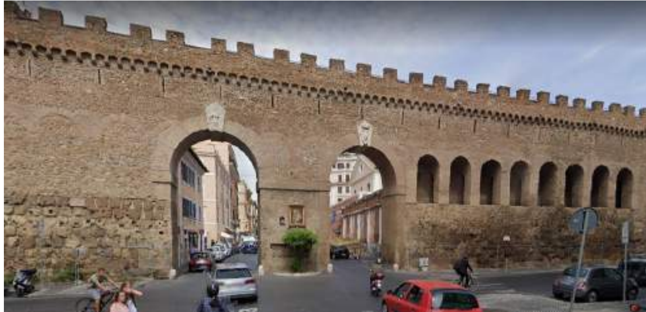
Figura 8-5 Fornici del Passetto di Borgo lungo Borgo S. Spirito incrocio via della Traspontina sotto i quali è in progetto il passaggio dell'infrastruttura tranviaria
